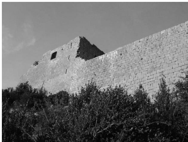
Figura 1.27a. Els murs sòlids de Montsegur estan fets de blocs massius ben encaixats entre si i subjectats amb ciment. Fotografia 2006.
